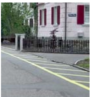
Una tale demarcazione sulla strada che confluisce in trasversale al traffico, è inammissibile per l'USTRA.
